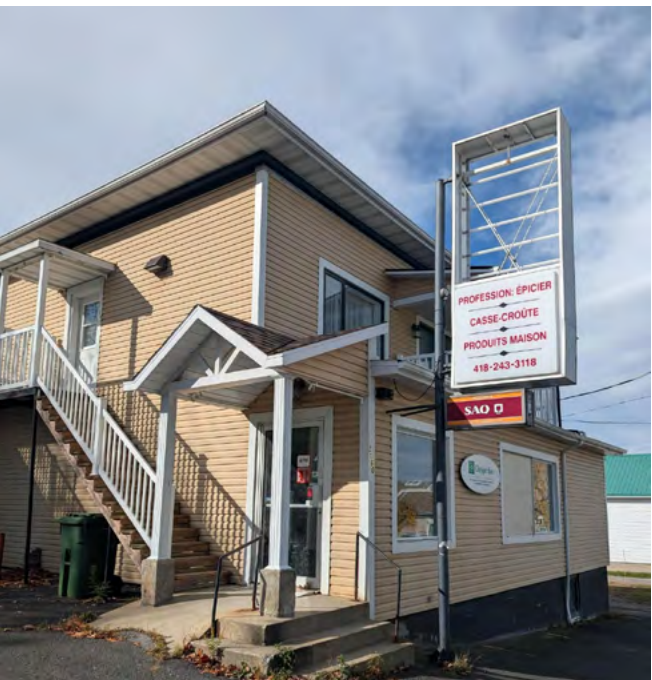
FIGURE 1 Bâtiment abritant un ancien point d'alimentation aujourd'hui fermé à Saint-Nérée
